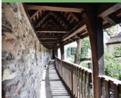
Chemin de garde des remparts.
