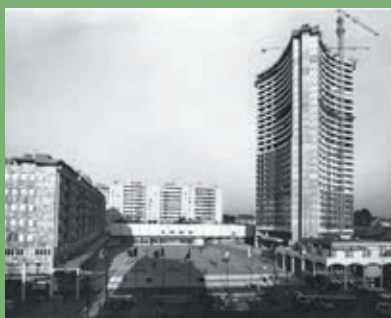
Tour de l'Europe en construction.
